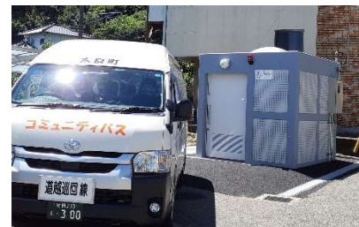
肥前大浦駅前の多目的水洗トイレ
