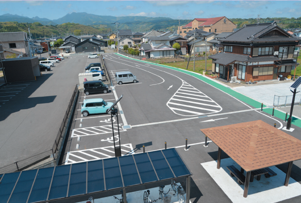
多良駅の利便性を高めるために整備しました。
