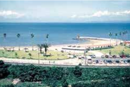
平成6年7月 海岸環境整備事業完了
