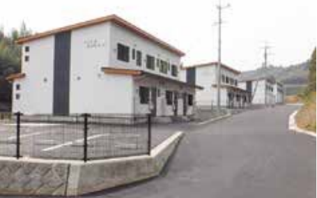
令和2年12月 亀ノ裏地区定住促進住宅「サンモールおおうら」完成
