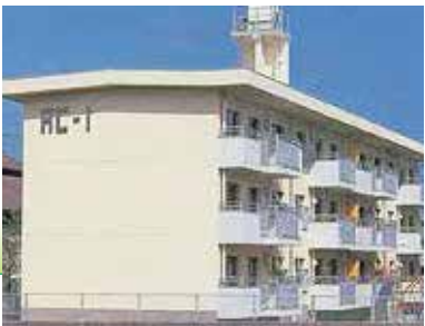
昭和58年 3 月 町営住宅畑田団地 1 号棟完成
