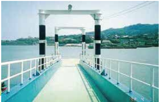
平成4年7月 大浦港浮桟橋完成
