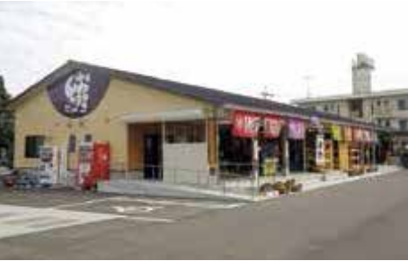
平成26年6月 太良町特産品等振興施設「しおまねき」新築工事完了
