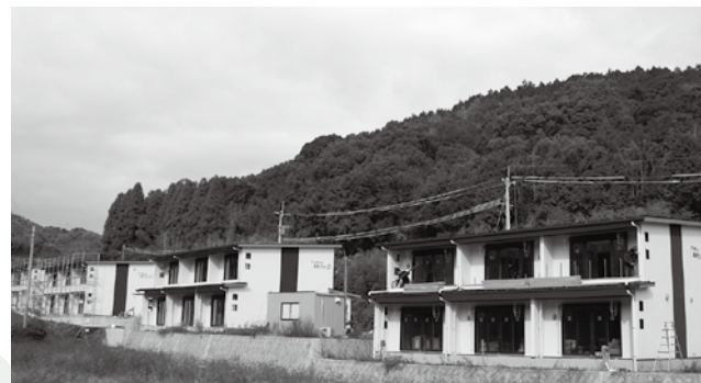
亀ノ浦地区定住促進住宅整備事業(4棟 建設中)
