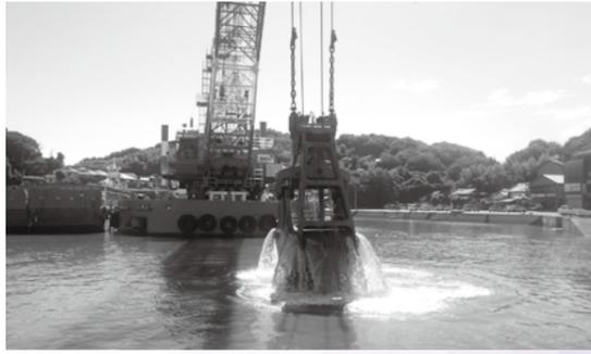
漁港浚渫工事(竹崎:海底の土砂撤去)
