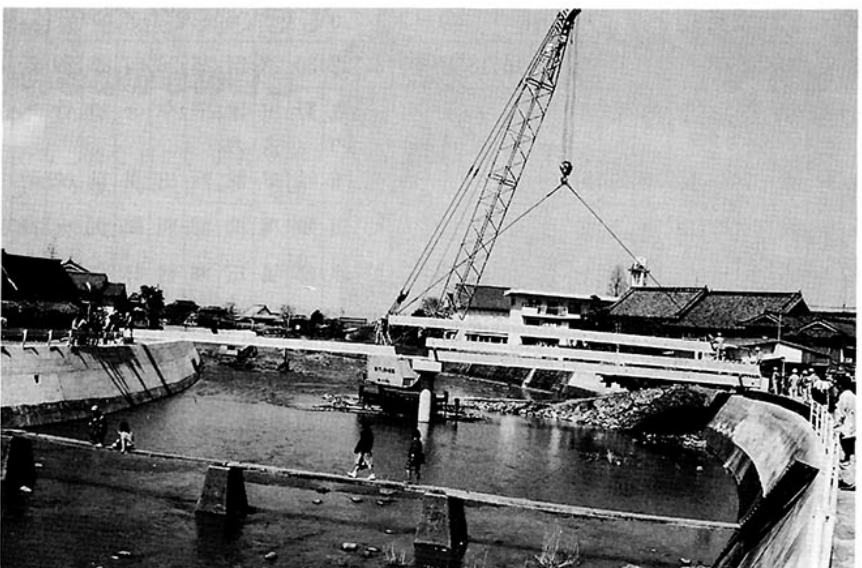
上部工の取り付け工事（手前に見えるのは、永年利用されてきたトントン橋）
