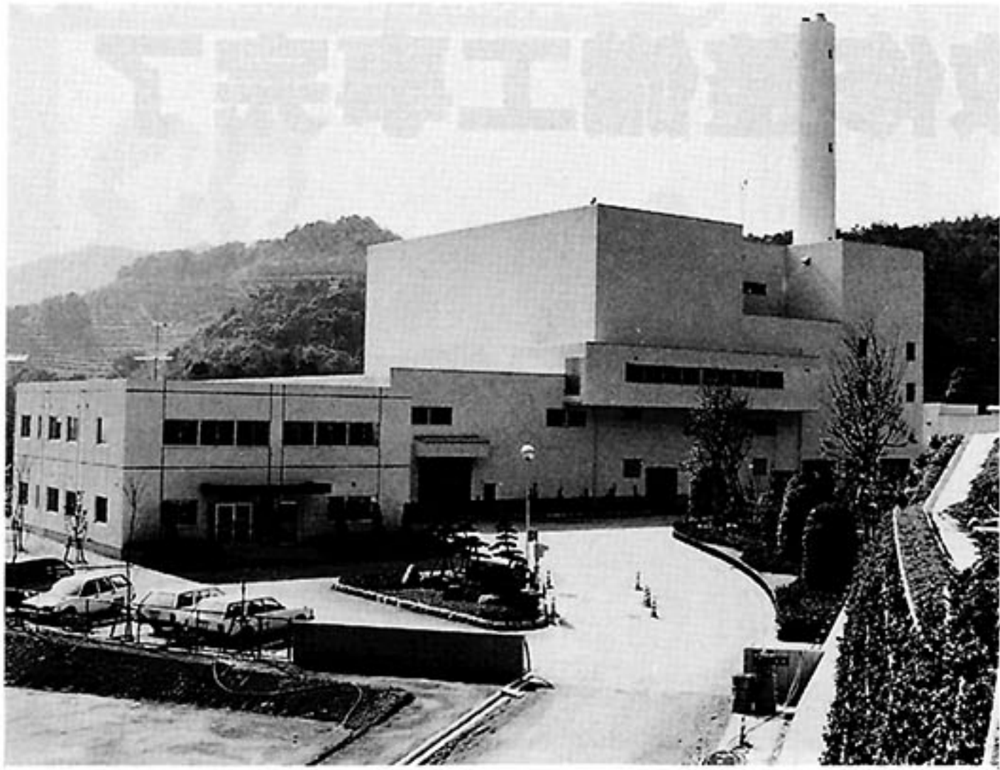
▲平成元年2月下旬完成 「杵藤クリーンセンター」
