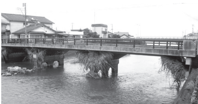
商工会館横の多良橋1号の様子
