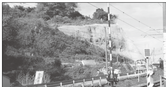
急ピッチで進む町道 栄町・北町線法面保護工事
