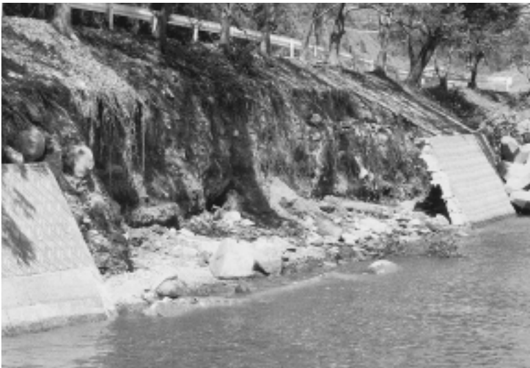
町道災害（破瀬ノ浦）
