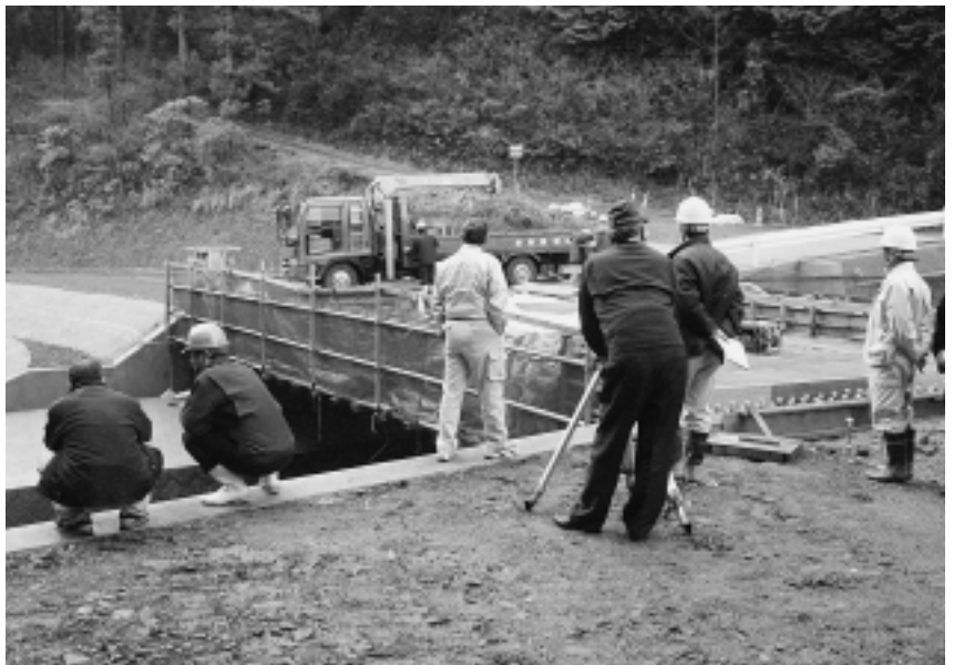
大野橋架け替え工事
