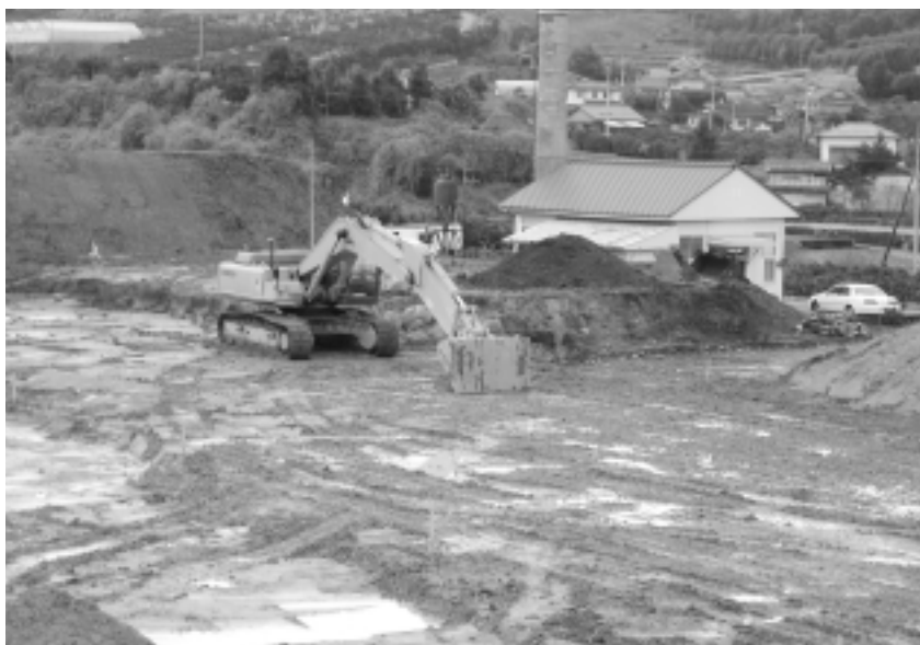
造成中の火葬場
