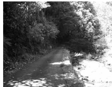
整備がまたれる山間部の道路
