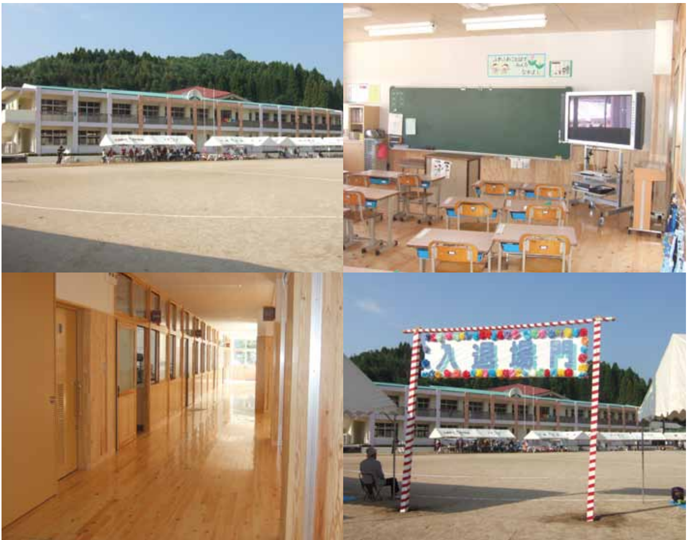
改築された大浦小管理棟と校舎内
