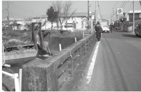
▲嫁川橋2号視察状況
