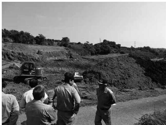
▲針牟田地区農地基盤整備事業 (現在工事中)
