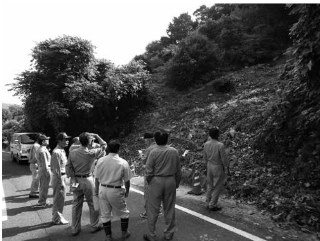
▲今夏の雨による被害状況を現地調査 ※町道端月線
